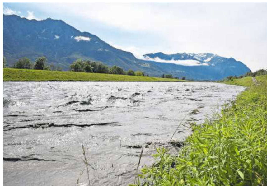
Die Sanierung der Rheindammabschnitte bei Sevelen, Triesen und Schaan beginnt bereits im Herbst 2021. Bild: Heini Schwendener
