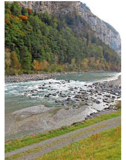
Die Blockrampe wurde zwischenzeitlich mehrmals saniert. Die letzte Sanierung erfolgte im Jahr 2002.
