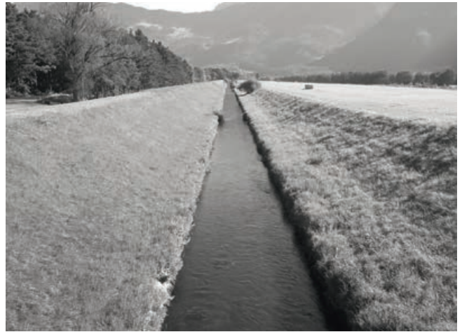
Abb. 7: Die Saar mit ihrem geometrischen Profil, den hohen Dämmen sowie dem Verlauf mitten durch den «Restraum» zwischen Autobahn und Rhein dominiert eine grosse Fläche nördlich der Strassenbrücke Balzers – Trübbach. Mit einer bewussten Neuorganisation dieser Raumkammer würde sich an dieser Stelle der Blick in eine grosszügige Flusslandschaft öffnen.
