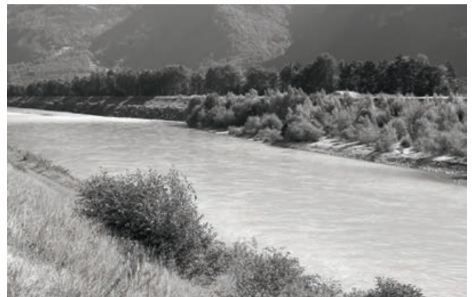
Abb. 4: Auf einer Kiesbank auf der Höhe des Kieswerks Balzers sind Gehölze aufgekommen, welche den Blick auf den Blockwurf und die geometrische Dammkronen weitgehend verdecken. Das Beispiel vermittelt einen Eindruck von der Wirkung eines natürlichen Uferbewuchses. Sie wird sich mit den Aufweitungen über eine bedeutenden Teil der einsehbaren Distanz einstellen.
